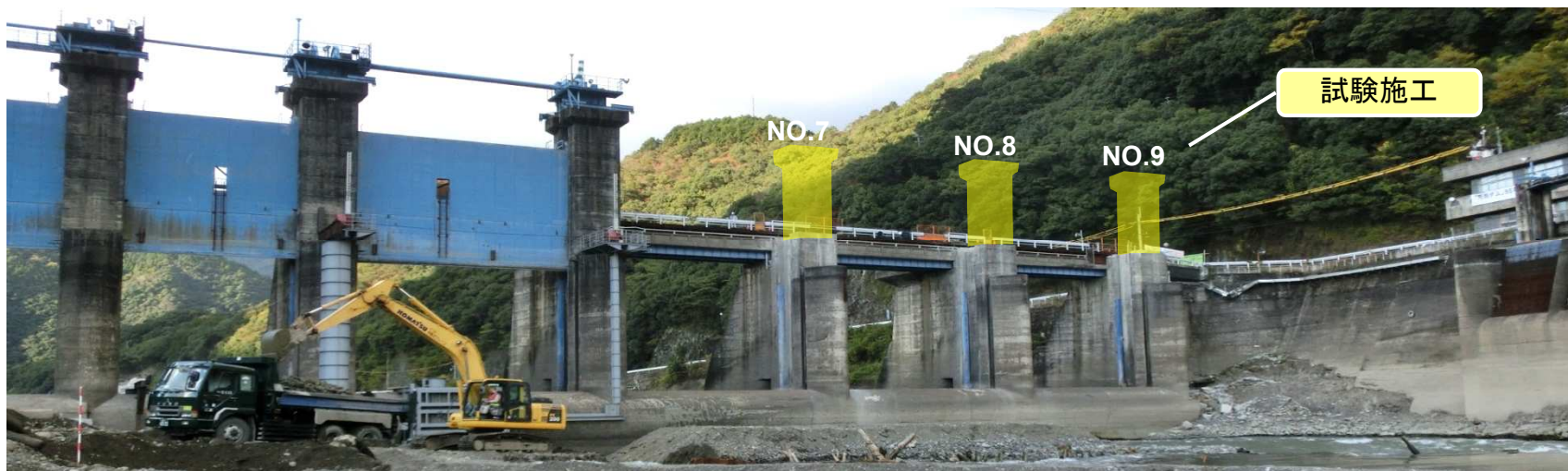
試験施工（コンクリート切断）
