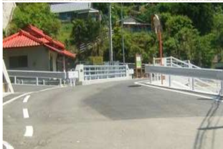
三坂橋嵩上 (H24工事)
