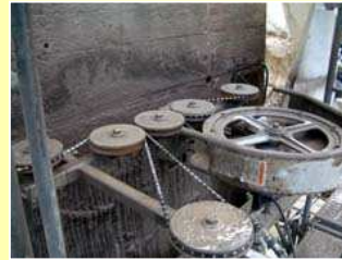
コンクリート切断
