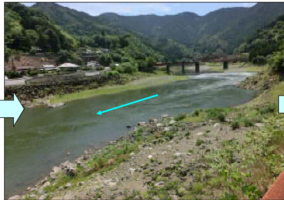
水位低下完了直後(平成25年6月17日)
