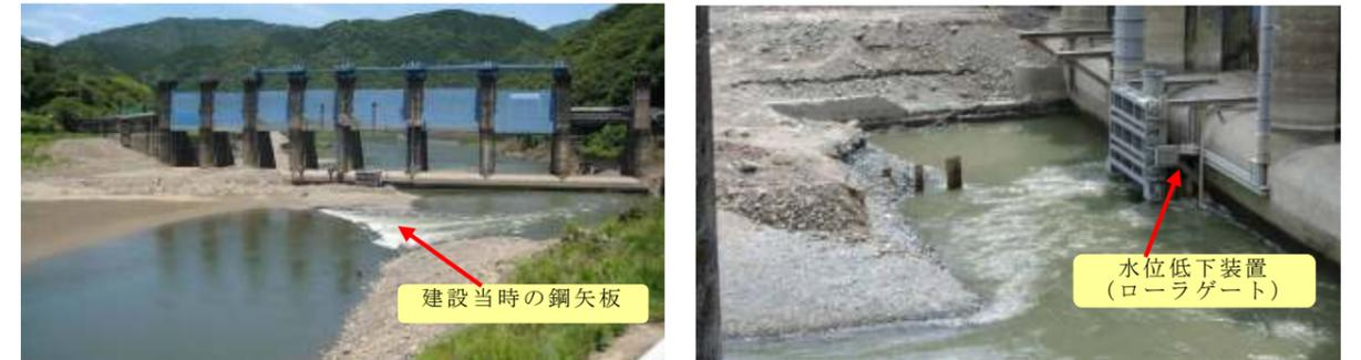
図-1.1 水位低下後のダム上流状況
