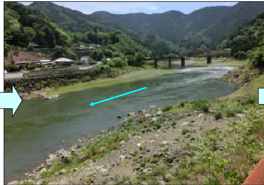
水位低下完了直後(平成25年6月17日)
