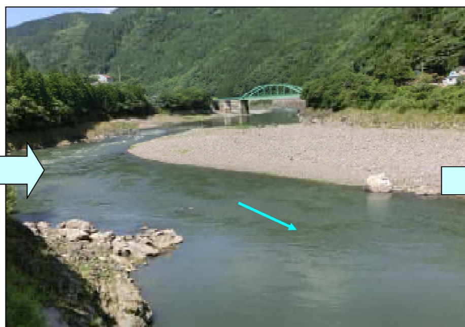
水位低下完了直後(平成25年6月17日)
