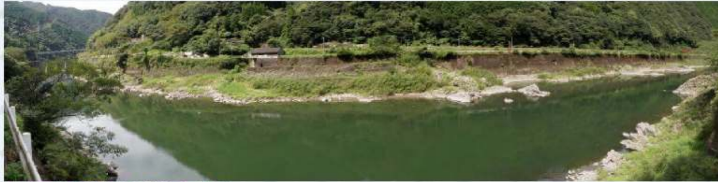
国道側から撮影(左が瀬戸石ダム)
