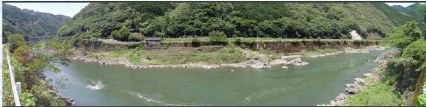
国道側から撮影(左が瀬戸石ダム)
