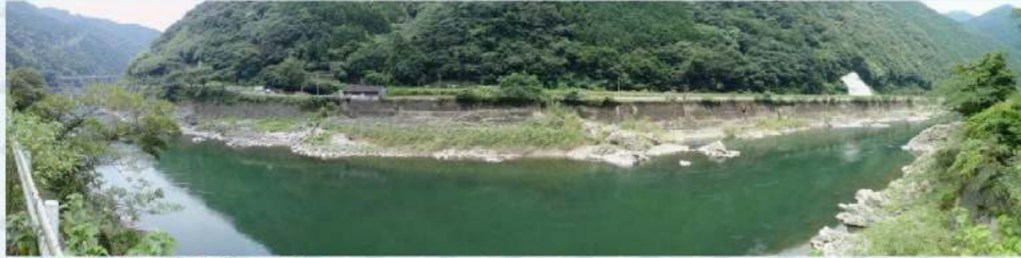
国道側から撮影(左が瀬戸石ダム)
