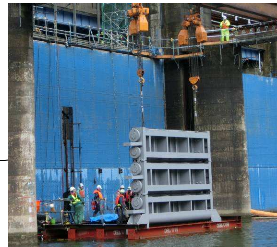
③ローラーゲート設置
