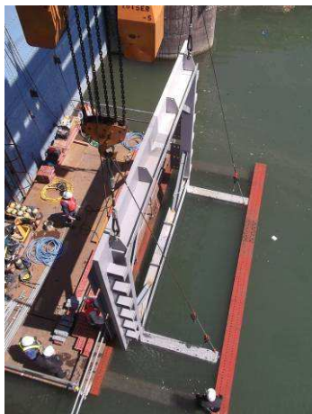
①受枠(下流)設置
