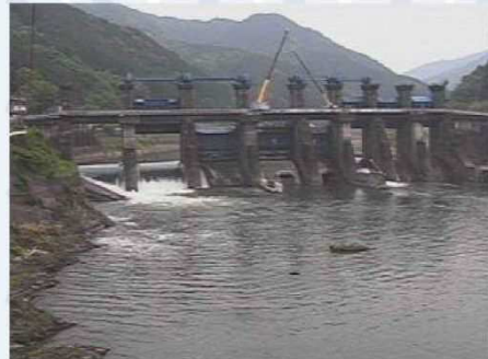
堤体(下流から)
