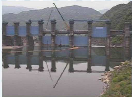
堤体(上流から)
