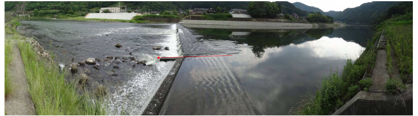
地点番号 St. 1-6 地点名 もぐり橋2 調査日 平成24年6月14日
