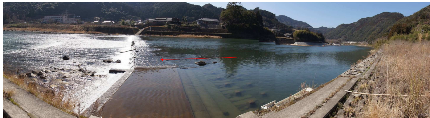
地点番号 St. 1-6 地点名 もぐり橋2 調査日 平成23年2月22日
