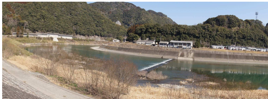
地点番号 St. 1-4 地点名 もぐり橋1 調査日 平成23年2月22日
