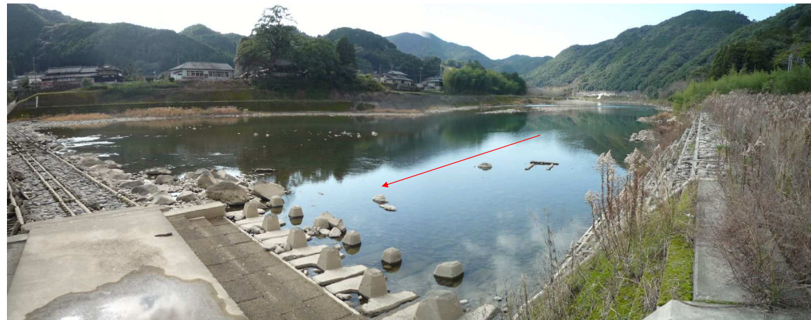
地点番号 St. 1-6 地点名 もぐり橋2 調査日 平成21年12月22日
