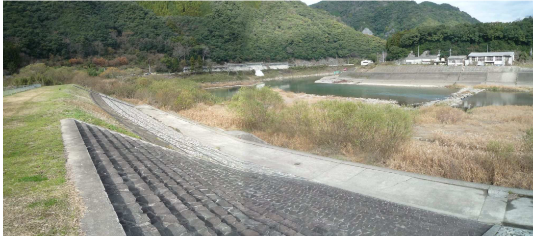
地点番号 St. 1-4 地点名 もぐり橋1 調査日 平成21年12月22日
