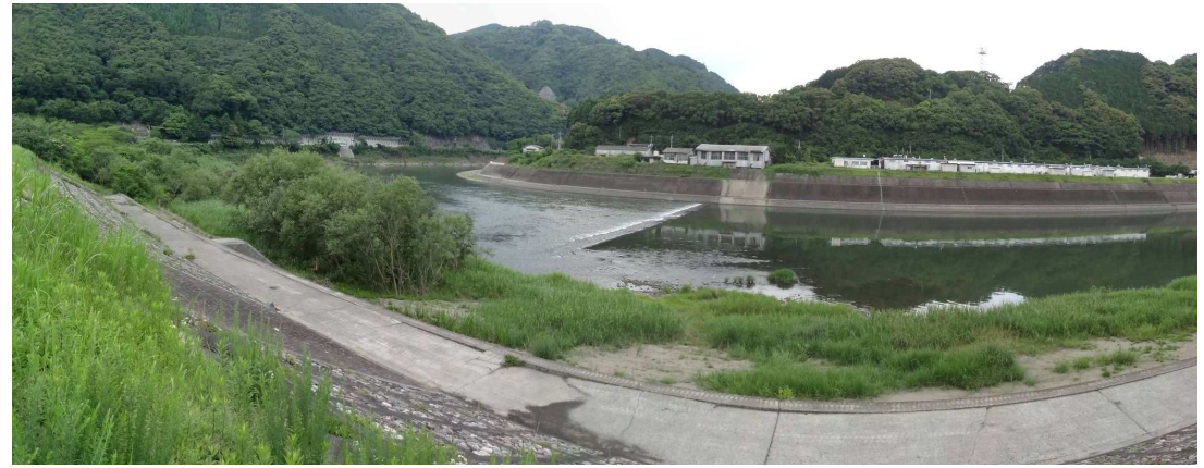
地点番号 St. 1-4 地点名 もぐり橋1 調査日 平成24年6月14日
