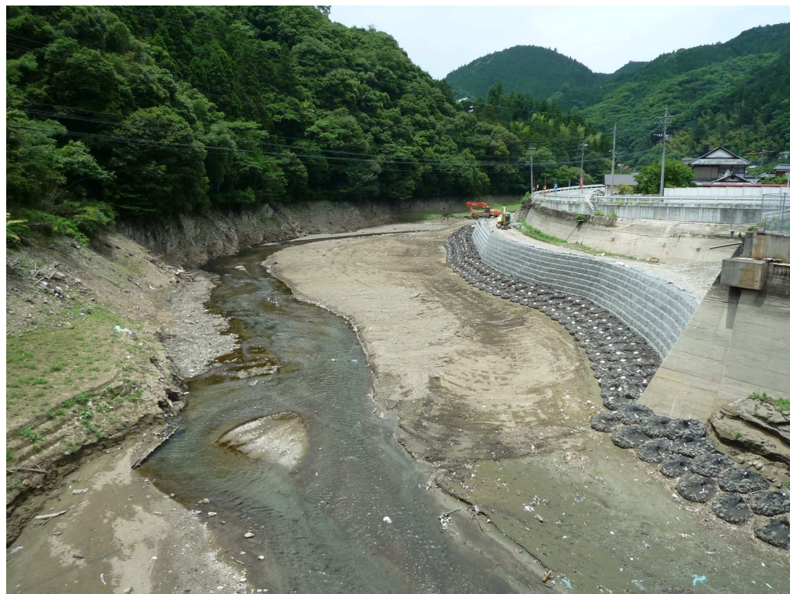
ゲート開放後(平成22年6月撮影)
