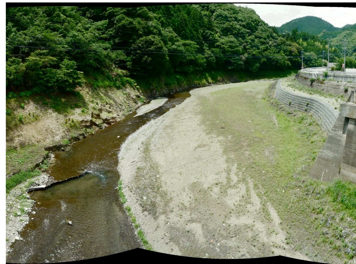
ゲート開放後(平成24年6月撮影)
