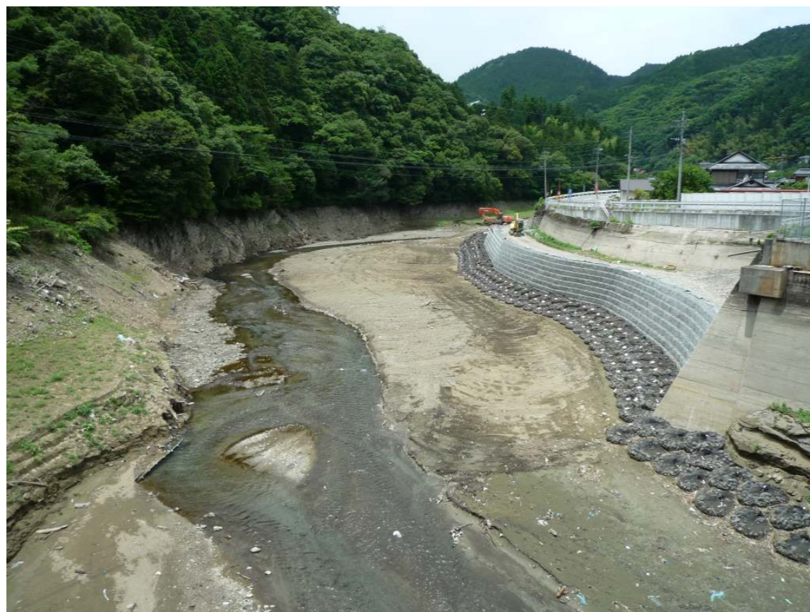
ゲート開放後(平成22年6月撮影)
