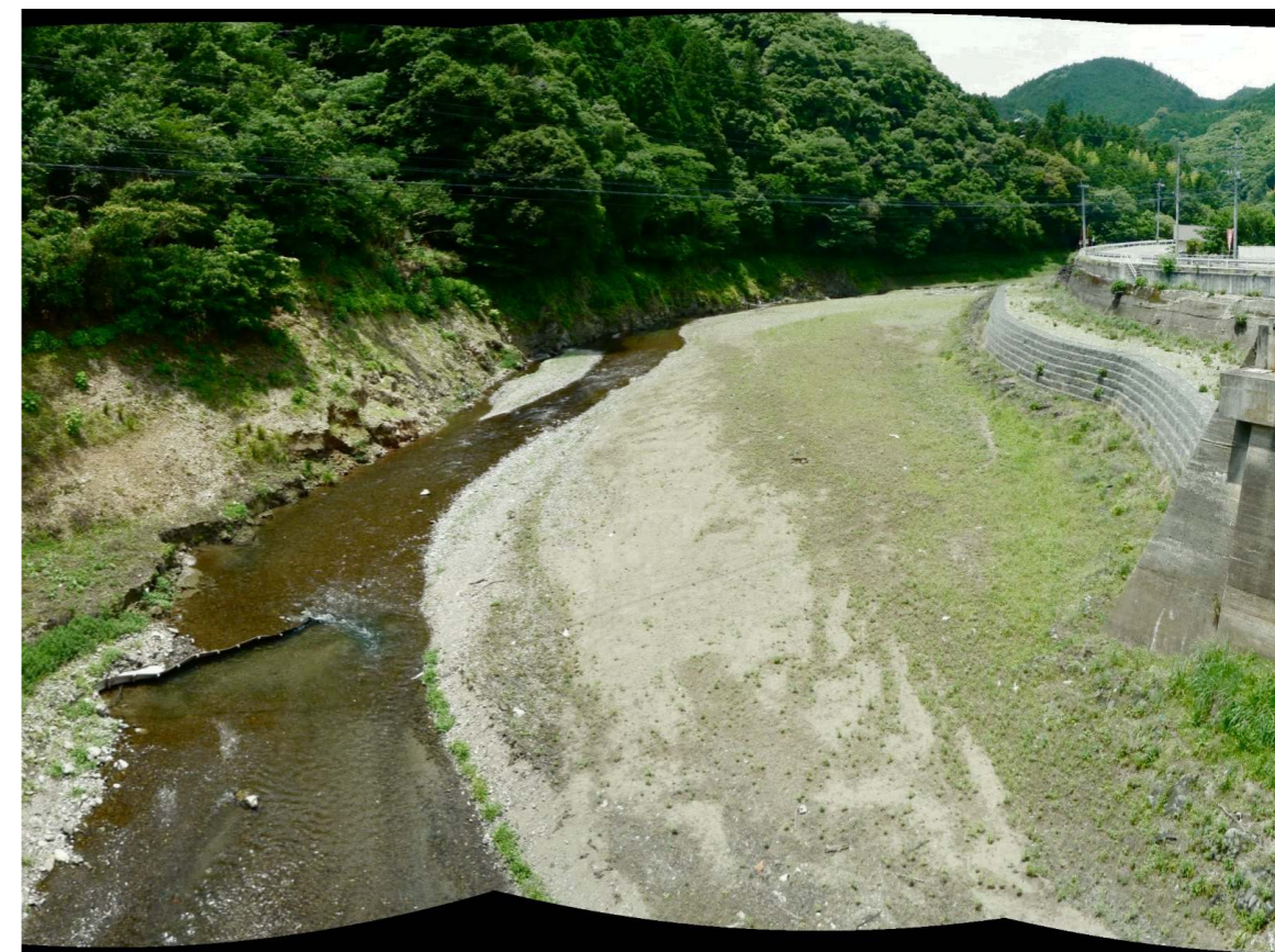
ゲート開放後(平成24年6月撮影)
