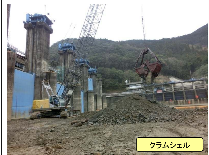
土砂掘削状況
