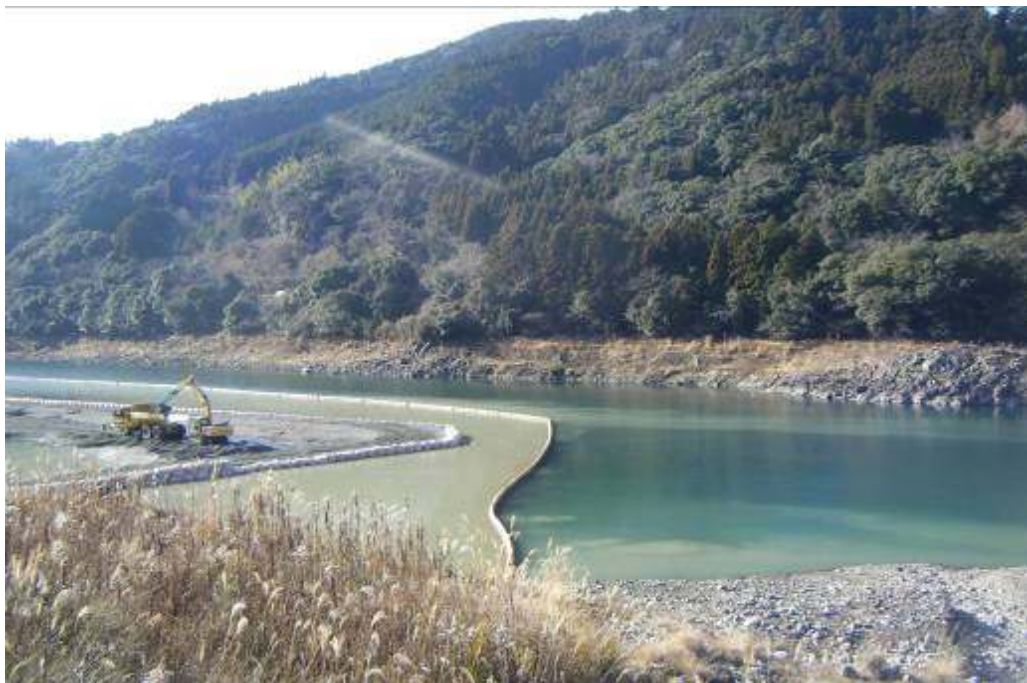
H23年度の泥土除去工事（佐瀬野地区）の状況
