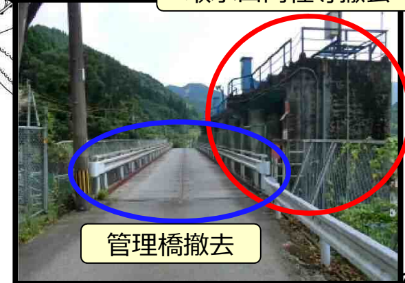
取水口門柱等撤去
