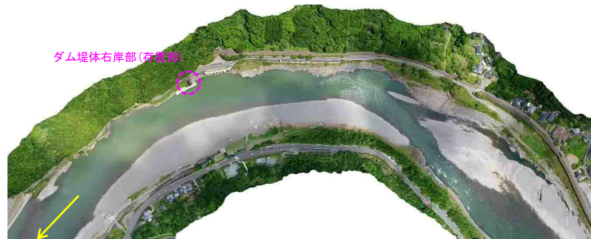
図 ダム堤体右岸側の残存部
