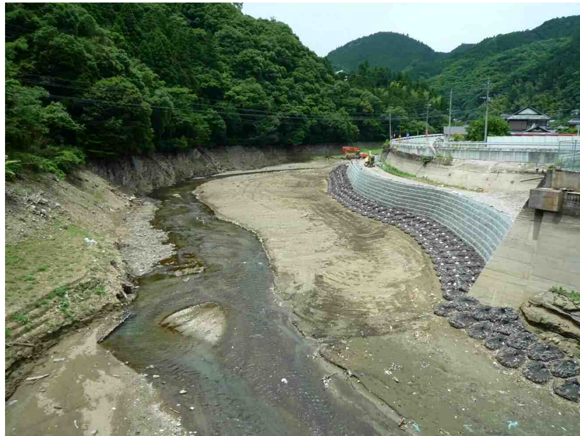
第1次水位低下後（平成22年6月撮影）
