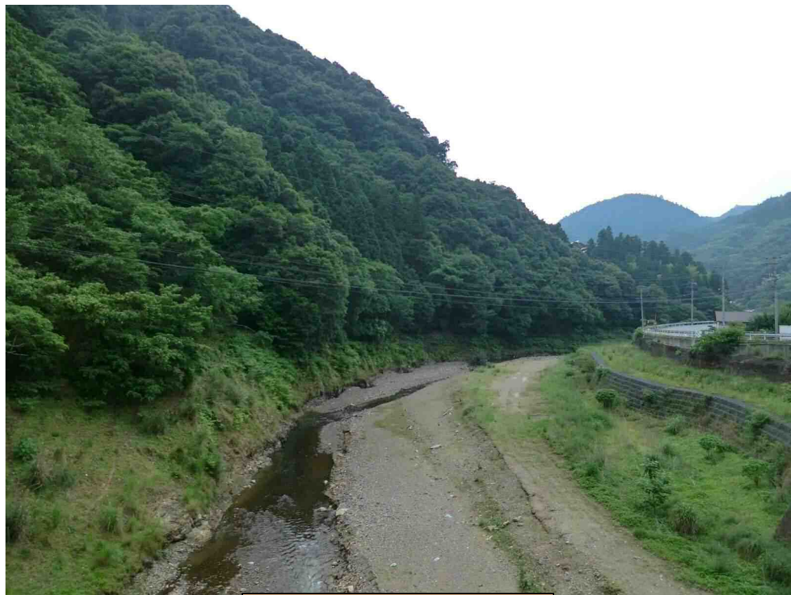
みお筋部撤去後（平成27年6月撮影）
