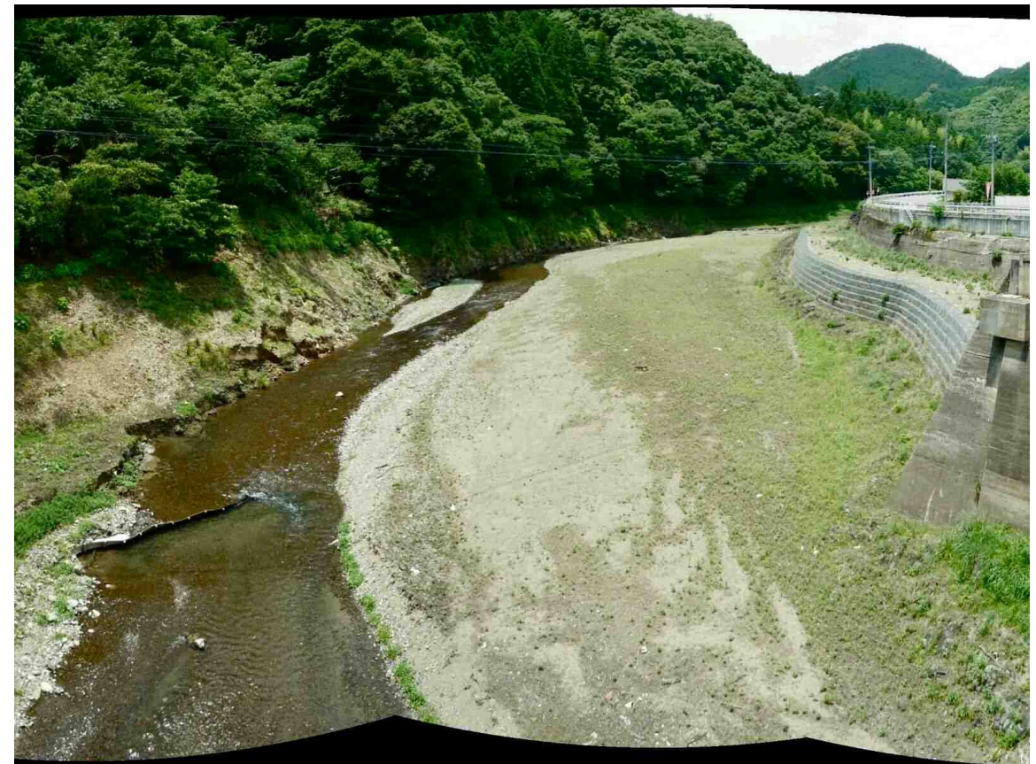
第1次水位低下後（平成24年6月撮影）
