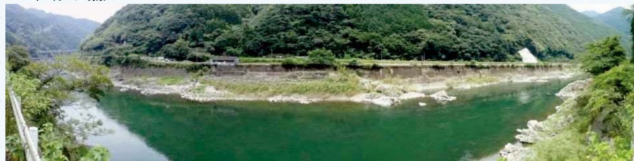
国道側から撮影(左が瀬戸石ダム)
