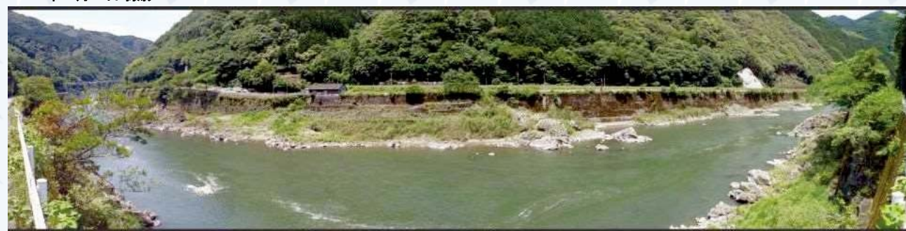
国道側から撮影(左が瀬戸石ダム)
