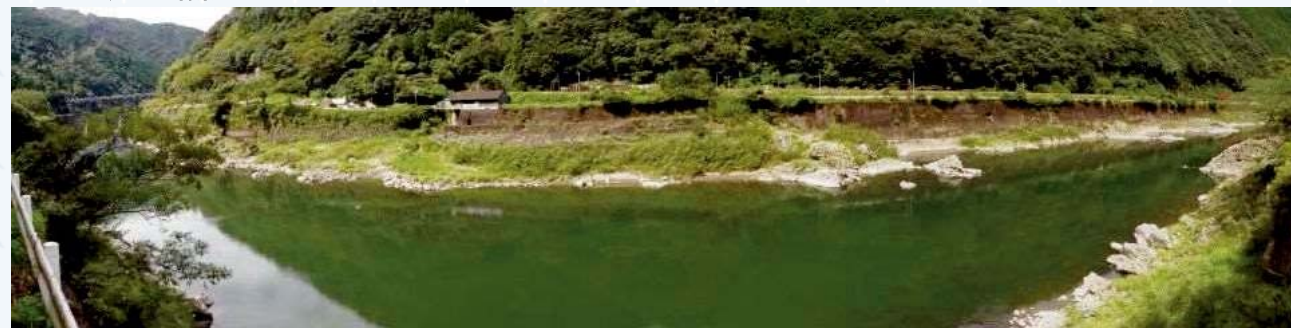
国道側から撮影(左が瀬戸石ダム)
