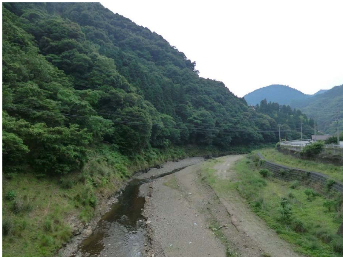
みお筋部撤去後（平成27年6月撮影）
