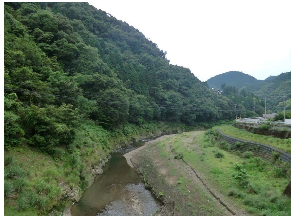
みお筋部撤去後（平成28年6月撮影）
