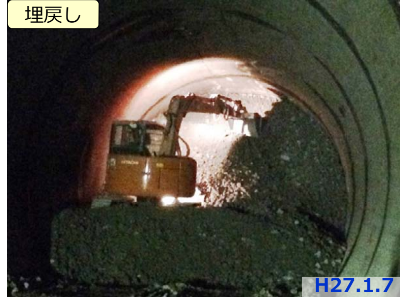
導水トンネル埋戻し第4期完了
