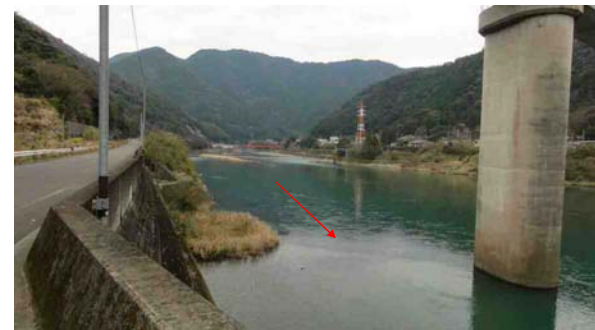
地点番号 St. 1-13 地点名 球磨川第一橋梁 調査日 平成26年3月8日
