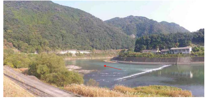
地点番号 St. 1-4 地点名 もぐり橋1 調査日 平成26年11月18日
