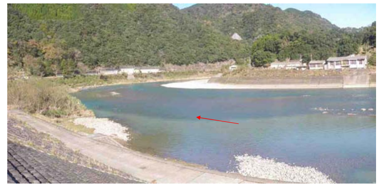
地点番号 St. 1-4 地点名 もぐり橋1 調査日 平成27年12月18日
