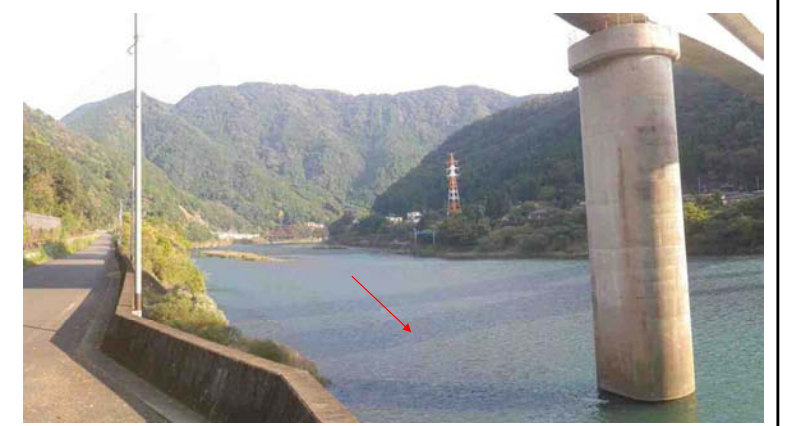
地点番号 St. 1-13 地点名 球磨川第一橋梁 調査日 平成26年11月18日
