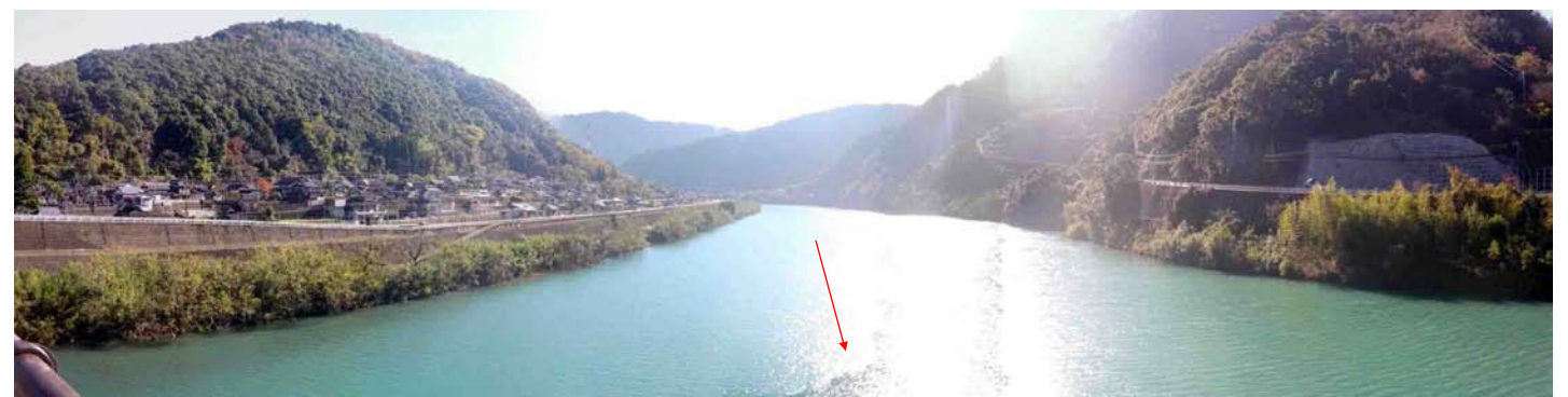
地点番号 St. 1-14 地点名 西部大橋 調査日 平成27年12月18日
