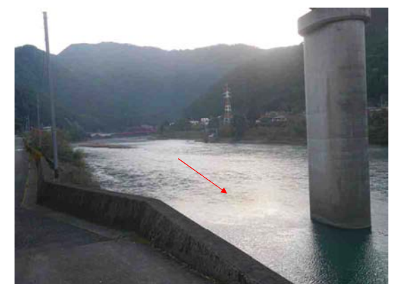
地点番号 St. 1-13 地点名 球磨川第一橋梁 調査日 平成27年12月18日
