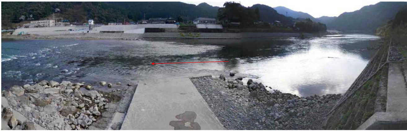
地点番号 St. 1-6 地点名 もぐり橋2 調査日 平成25年3月25日
