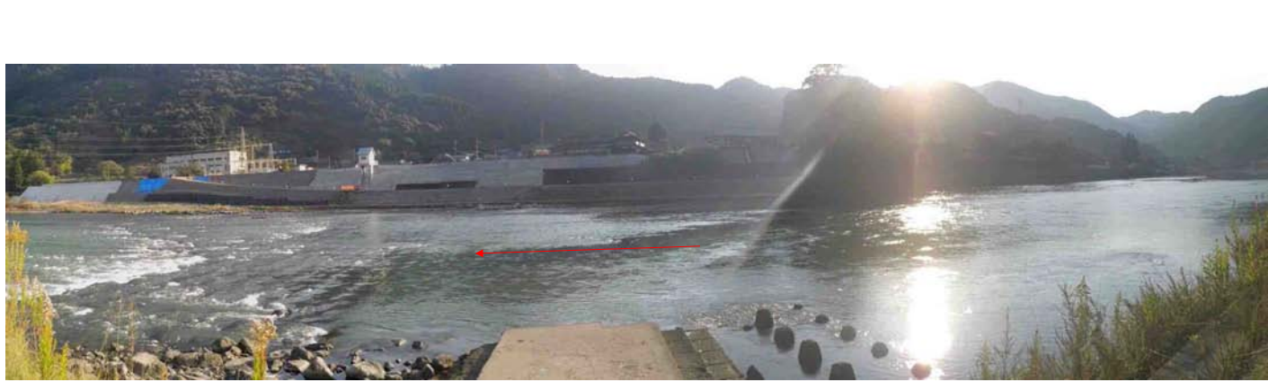
地点番号 St. 1-6 地点名 もぐり橋2 調査日 平成26年11月18日
