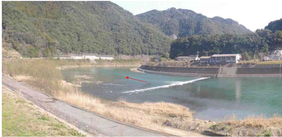
地点番号 St. 1-4 地点名 もぐり橋1 調査日 平成26年3月8日
