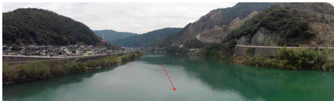
地点番号 St. 1-14 地点名 西部大橋 調査日 平成26年3月8日
