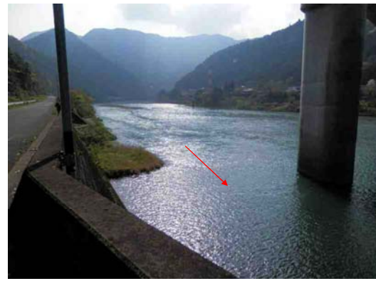
地点番号 St. 1-13 地点名 球磨川第一橋梁 調査日 平成25年3月25日
