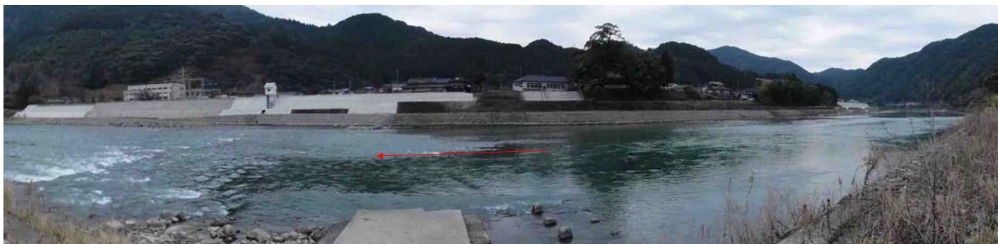
地点番号 St. 1-6 地点名 もぐり橋2 調査日 平成26年3月8日
