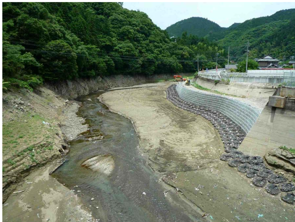
第1次水位低下後（平成22年6月撮影）
