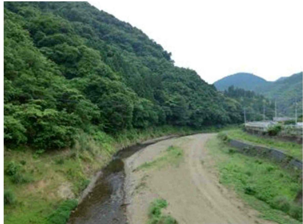
第2次水位低下後（平成26年6月撮影）
