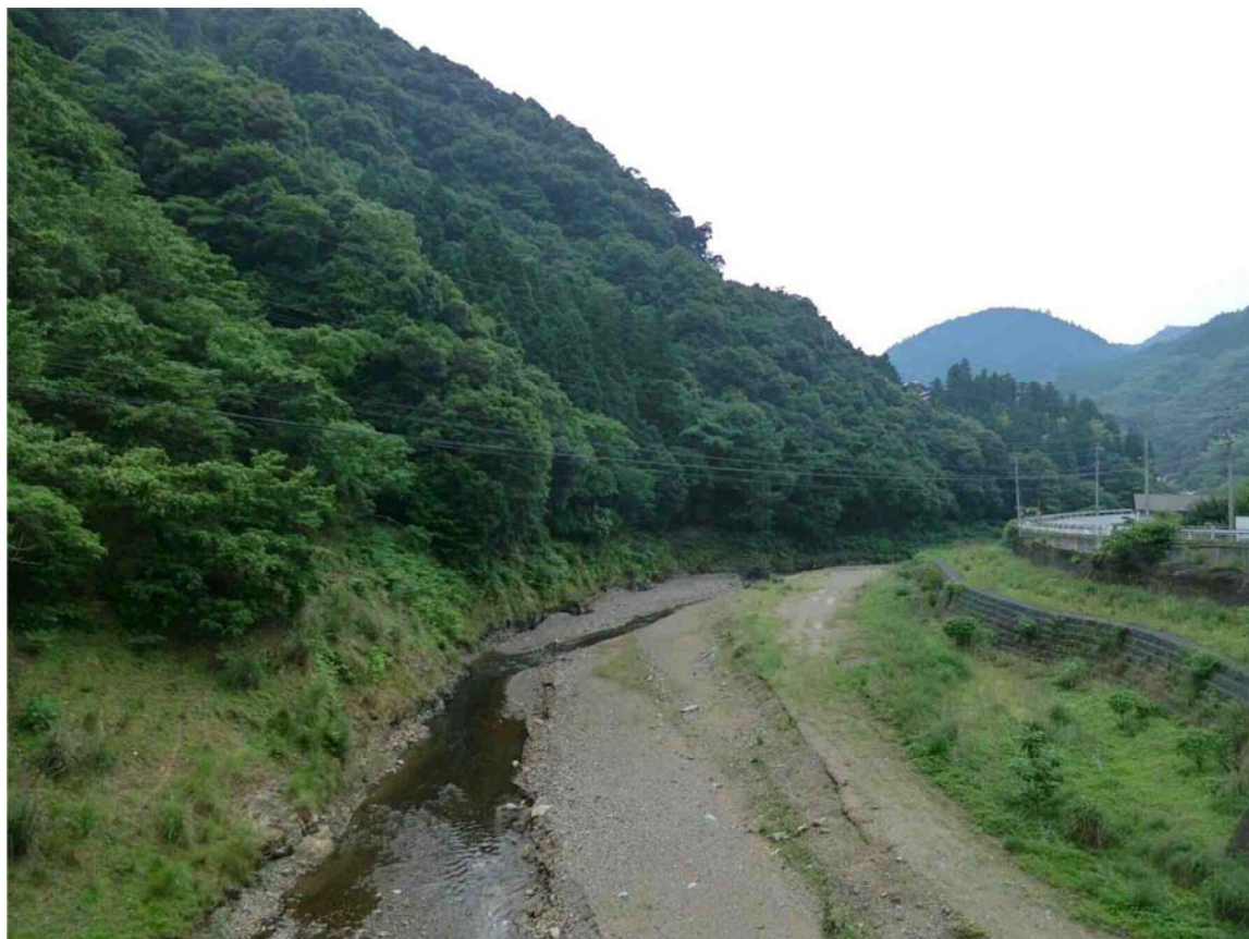
第2次水位低下後（平成27年6月撮影）
