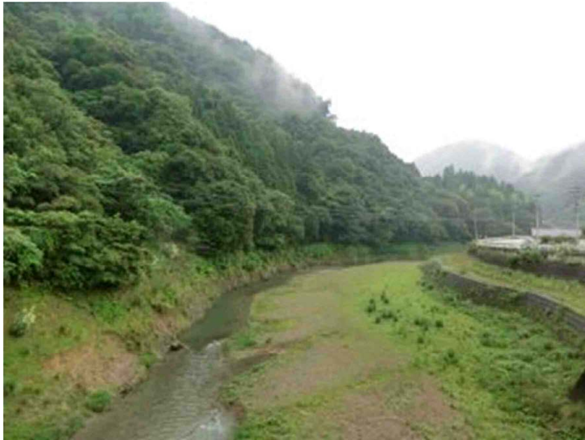
第2次水位低下後（平成25年6月下旬撮影）
