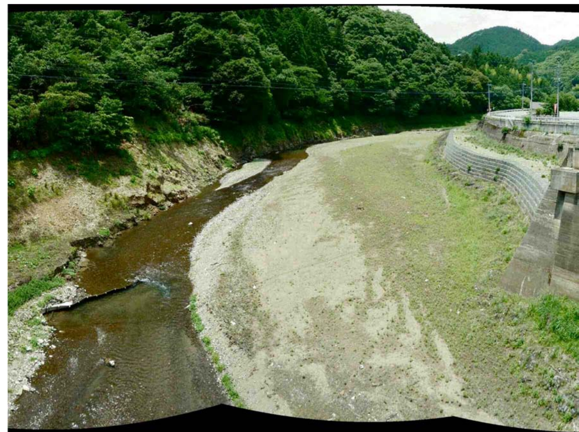
第1次水位低下後（平成24年6月撮影）
