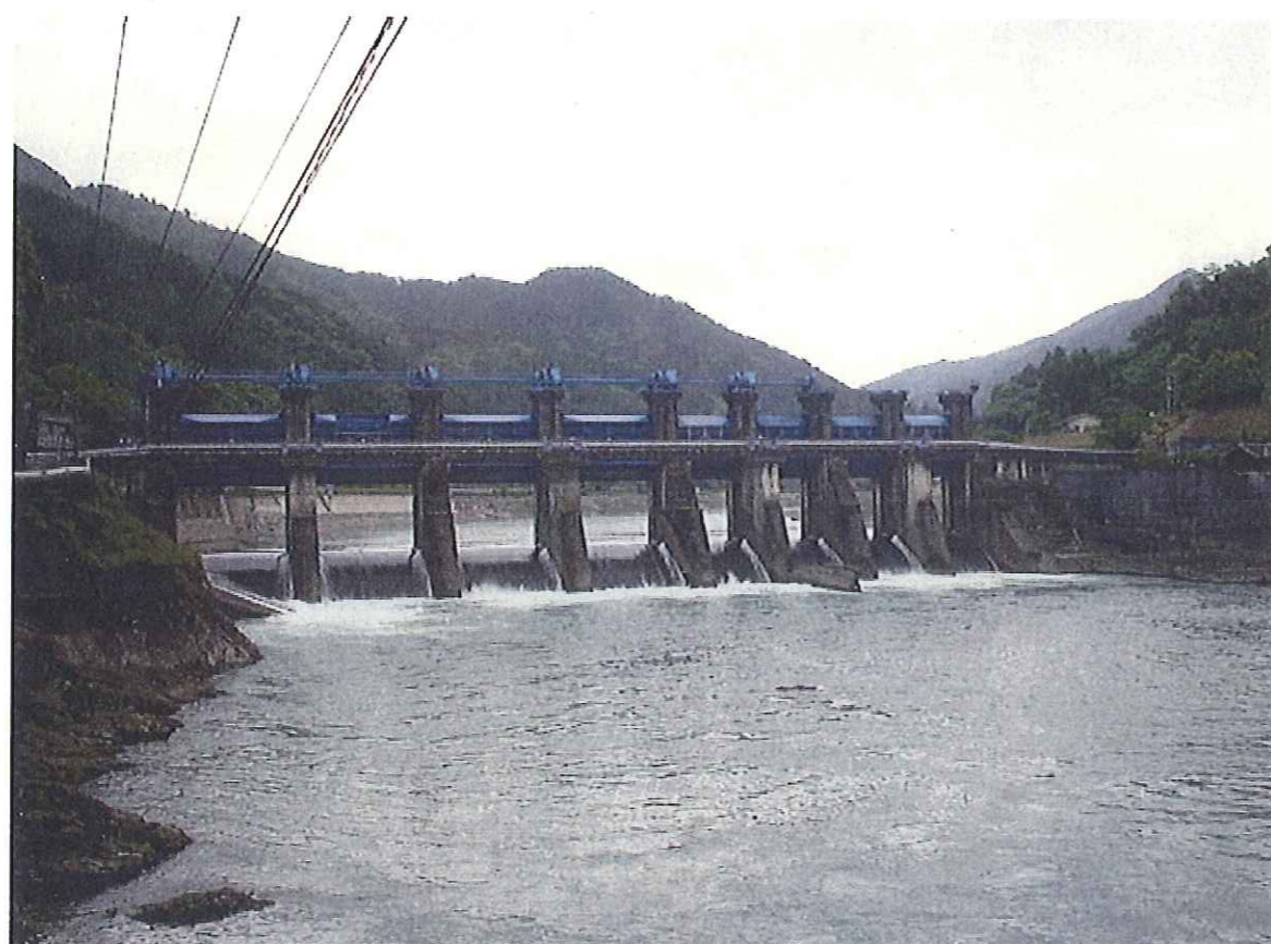
荒瀬ダム（下流側から上流を望む）
