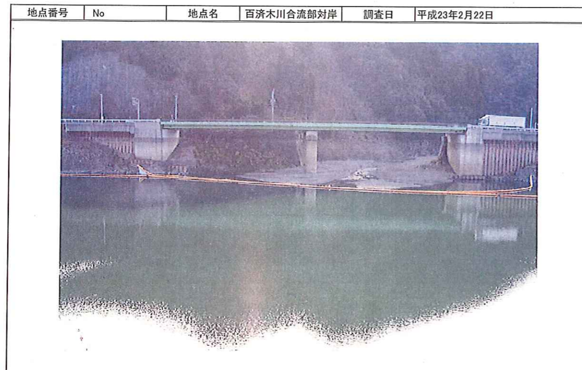
図 2-2-105 百済木川合流部対岸における河道内の現況
