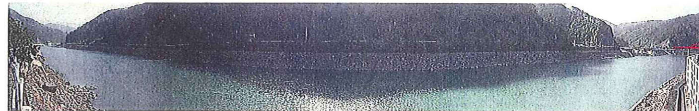
図14 荒瀬ダムボートハウス付近
