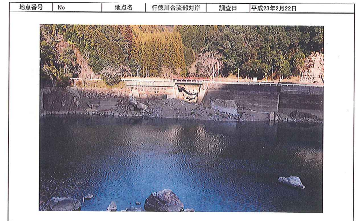
図 2-2-107 行徳川合流部対岸における河道内の現況
