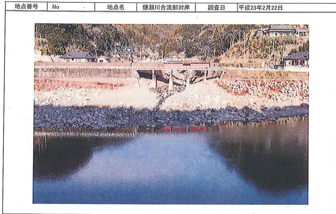
図 2-2-108 鎌瀬川合流部対岸における河道内の現況
