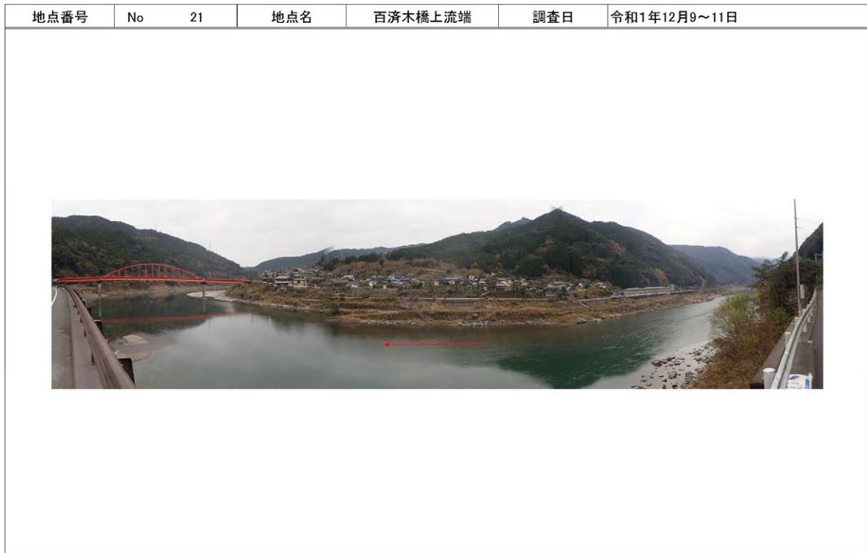
写真 9.2 (17) 河川形状に着目した地点 撮影写真
