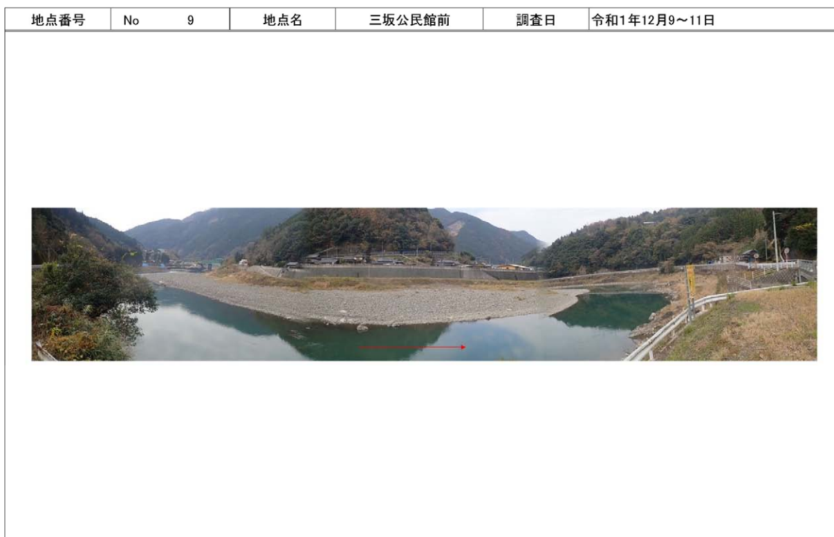
写真 9.2 (11) 河川形状に着目した地点 撮影写真
