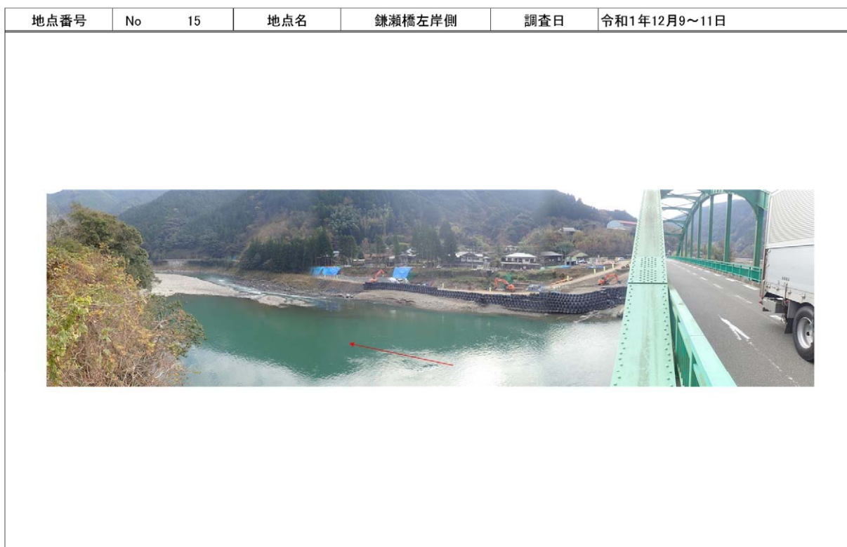
写真 9.2 (14) 河川形状に着目した地点 撮影写真
