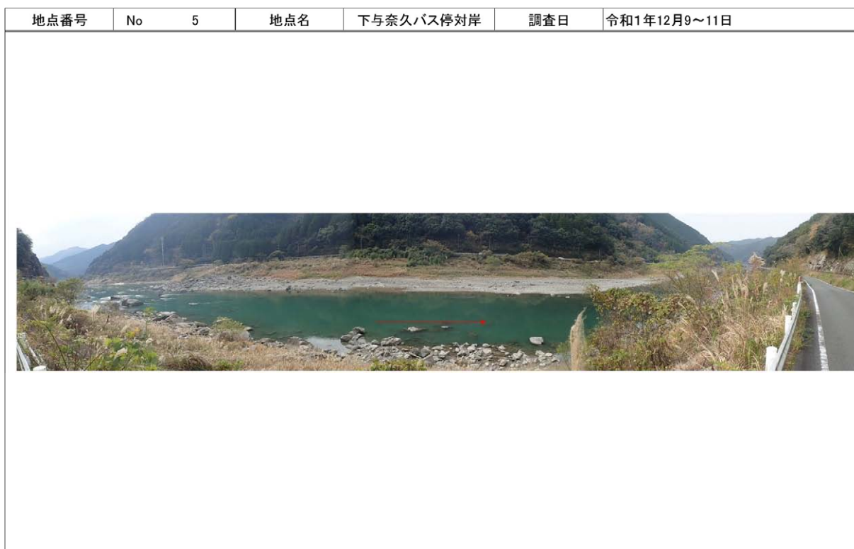
写真 9.2 (9) 河川形状に着目した地点 撮影写真
