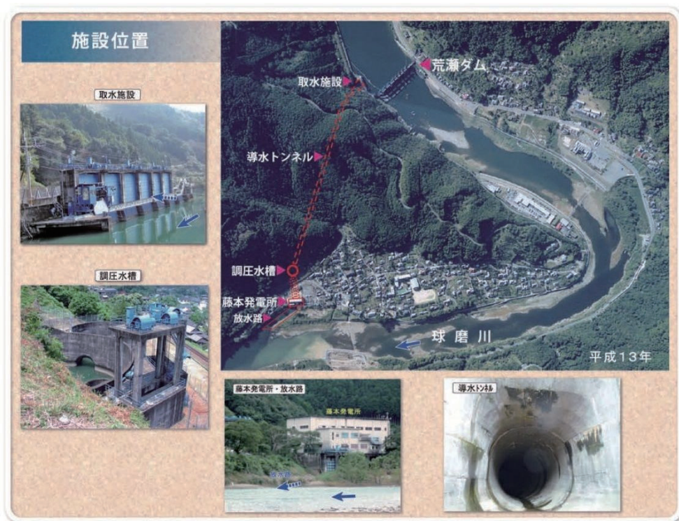
図 1.1.8 荒瀬ダム及び藤本発電所の施設位置及び概況写真
