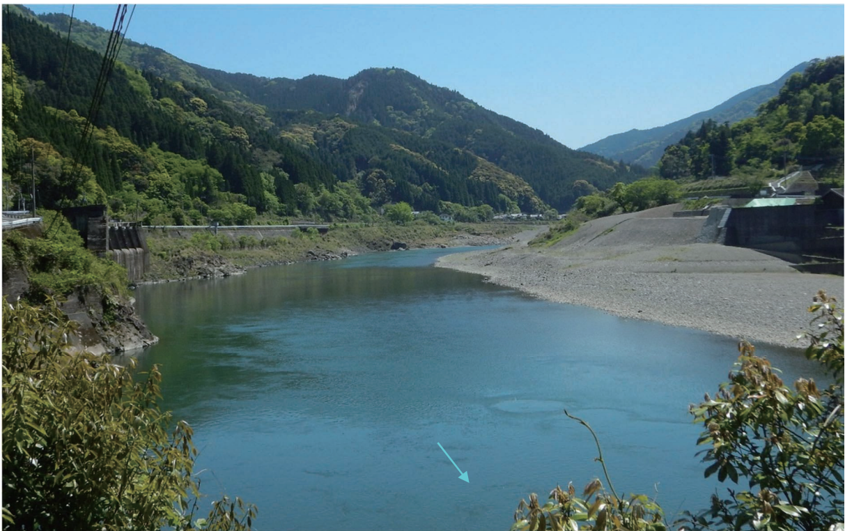
図 1.1.3 荒瀬ダム撤去完了後（平成 30 年 4 月 19 日：右岸下流より）
