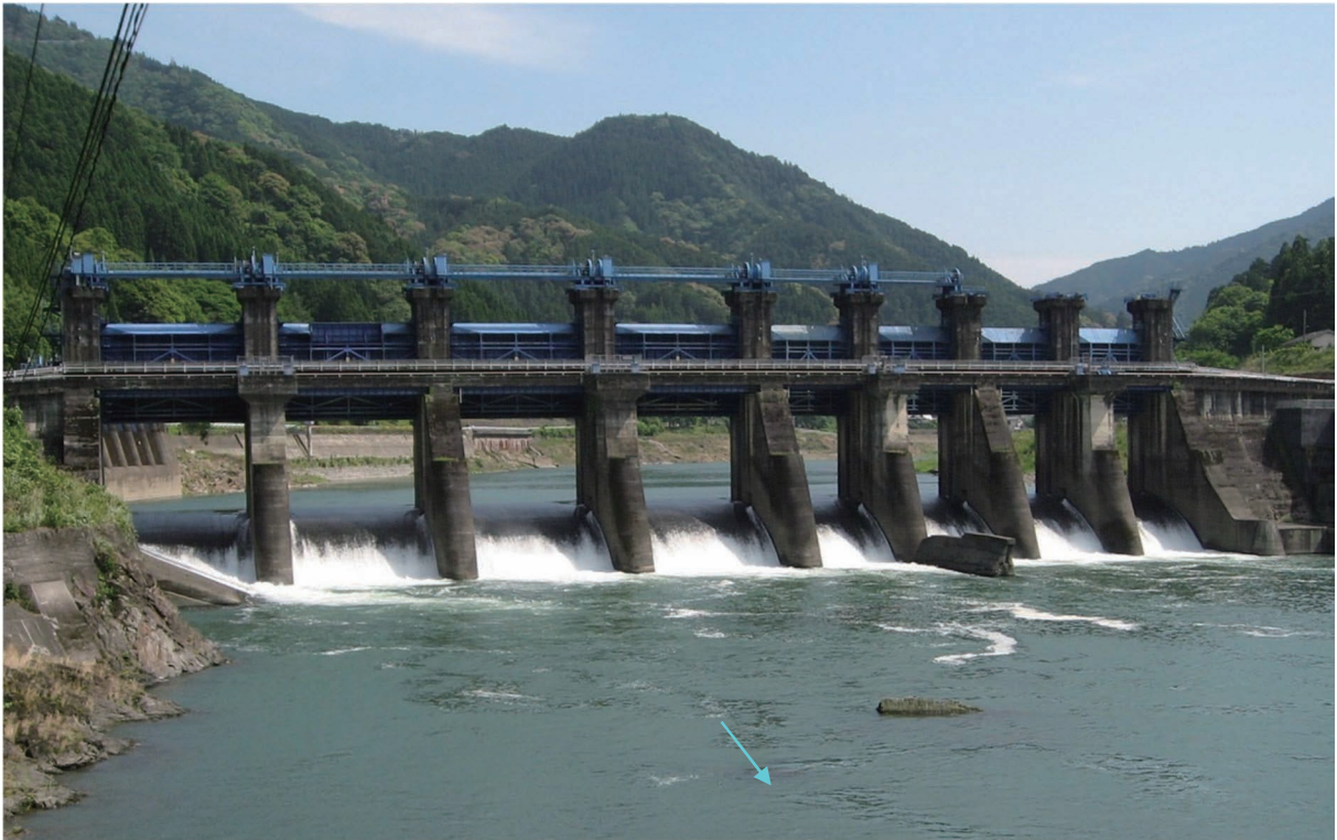
図 1.1.2 荒瀬ダム撤去着手前（平成 23 年 5 月 15 日：右岸下流より）
