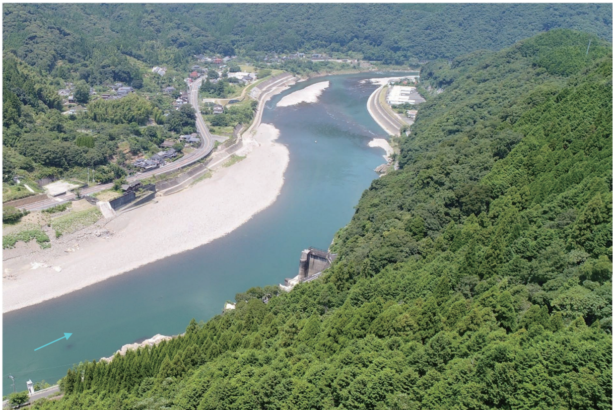
図 1.1.5 荒瀬ダム撤去完了後（平成 30 年 8 月 3 日：林道から望む）
