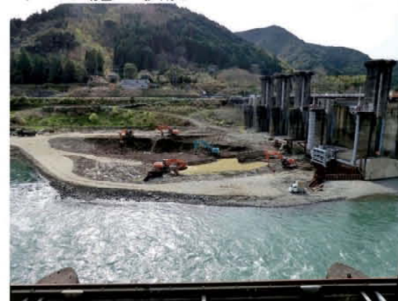
ヤード施工状況
