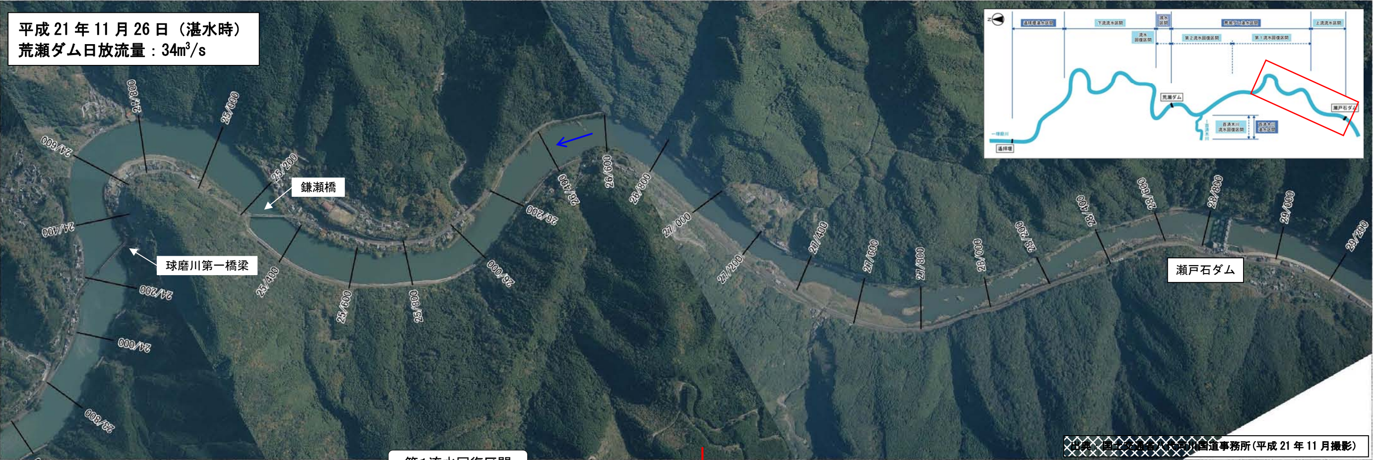
【第1流水回復区間・上流流水区間】（「第7回荒瀬ダム撤去フォローアップ専門委員会 資料」の再掲）
