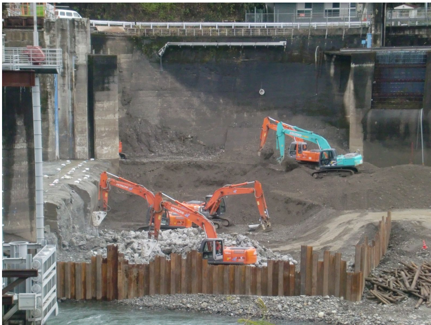
現地状況写真（構造物取壊し 平成26年12月11日）
