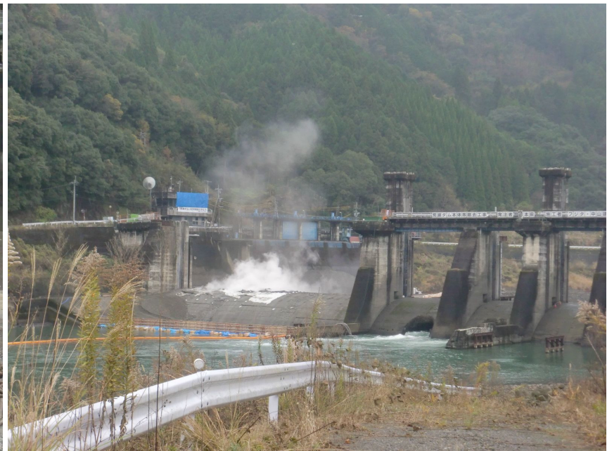
現地状況写真（発破 平成26年12月11日）
