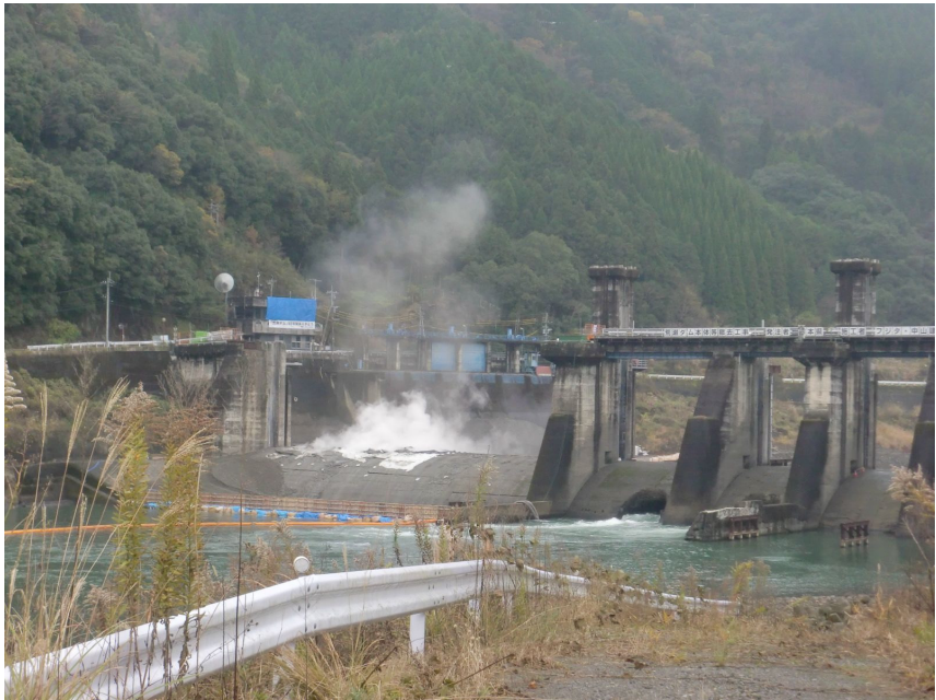
現地状況写真（発破 平成 26 年 12 月 11 日）
