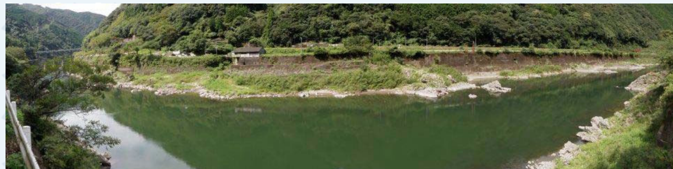
国道側から撮影(左が瀬戸石ダム)
