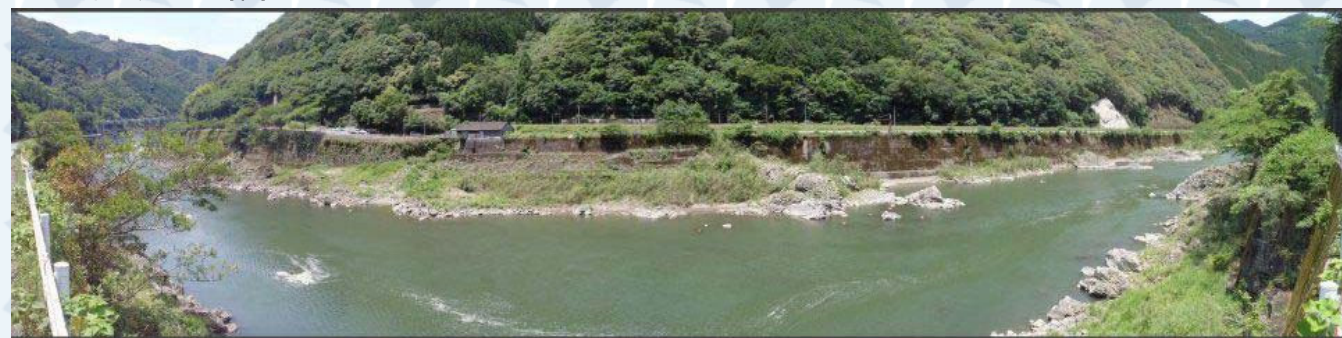
国道側から撮影(左が瀬戸石ダム)
