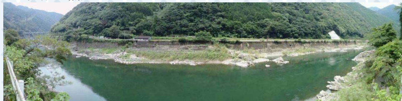
国道側から撮影(左が瀬戸石ダム)
