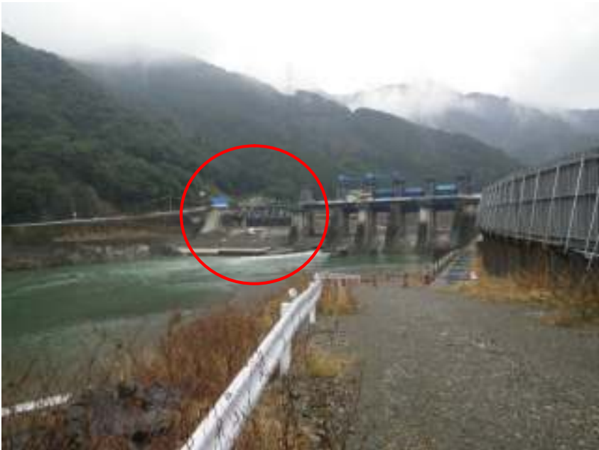
現地状況写真（発破）
