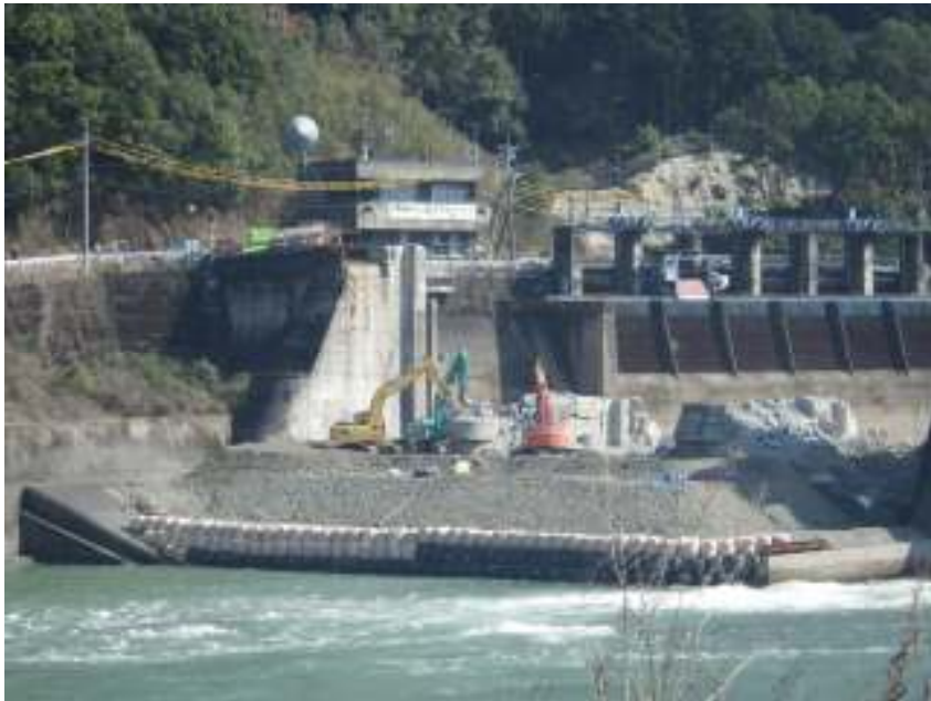
現地状況写真（大型ブレーカによる構造物取壊し）
