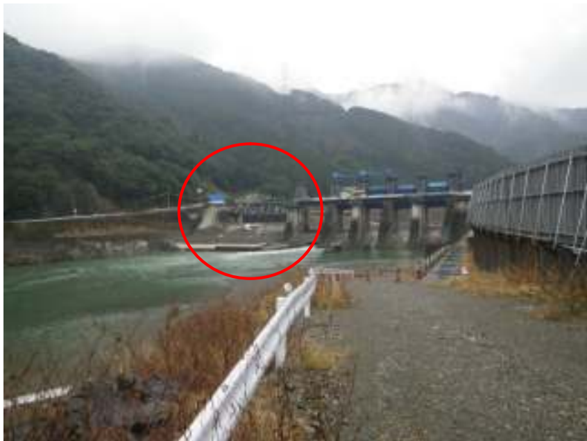
現地状況写真（発破）
