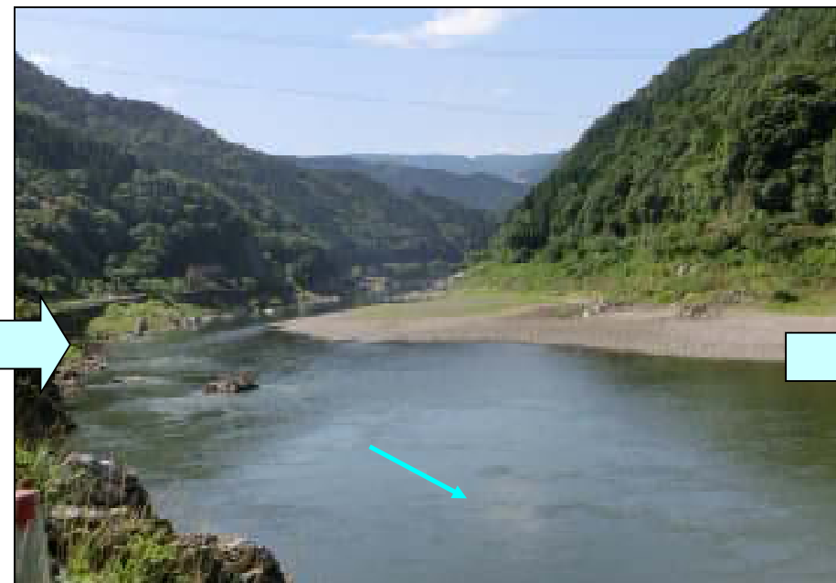
水位低下完了直後(平成25年6月17日)
