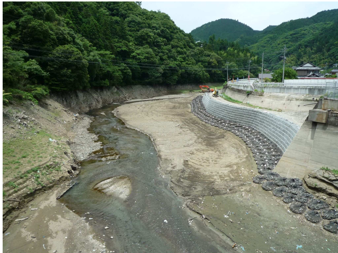
ゲート開放後（平成 22 年 6 月撮影）
