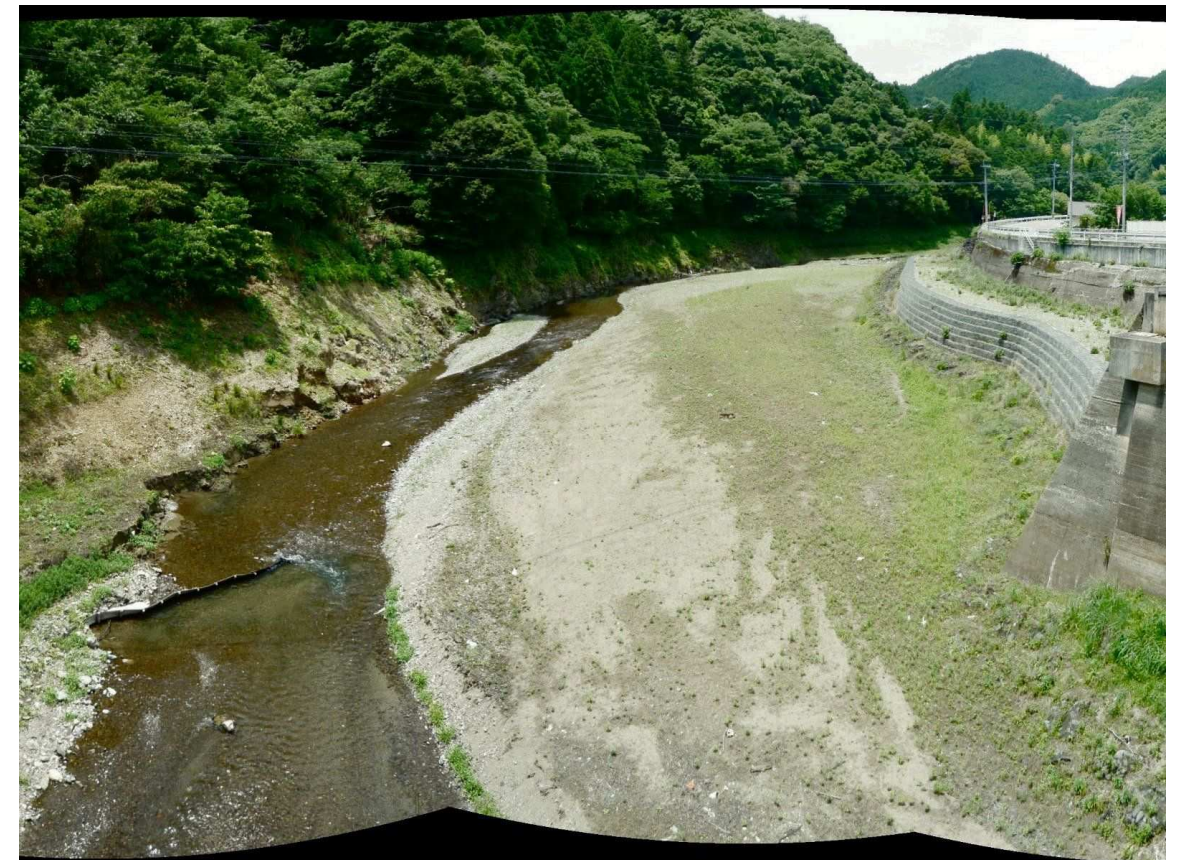
ゲート開放後（平成 24 年 6 月撮影）
