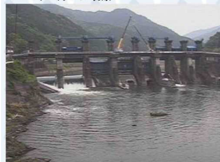
堤体(下流から)
