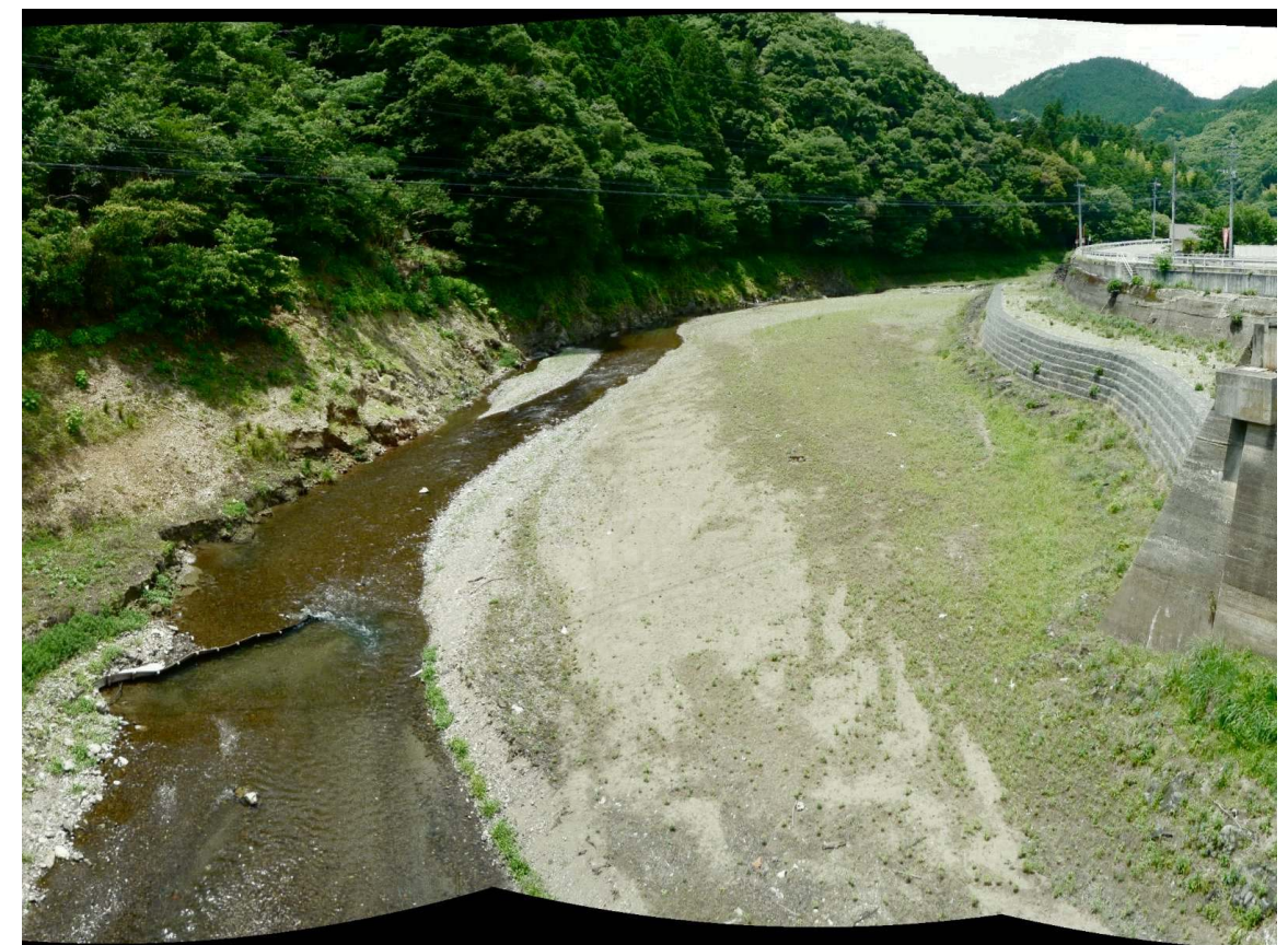
ゲート開放後（平成 24 年 6 月撮影）
