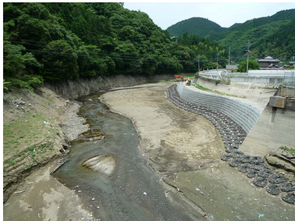
ゲート開放後（平成 22 年 6 月撮影）
