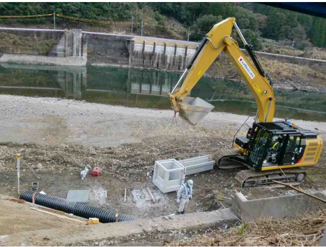
現地状況写真 (大型ショベルによる堤体周辺の整備作業取壊し)
