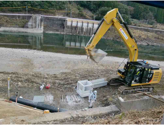
現地状況写真 (大型ショベルによる堤体周辺の整備作業取壊し)
