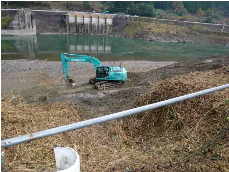
現地状況写真（平成 29 年 12 月 4 日） （大型ショベルによる堤体周辺の整備作業取壊し）
