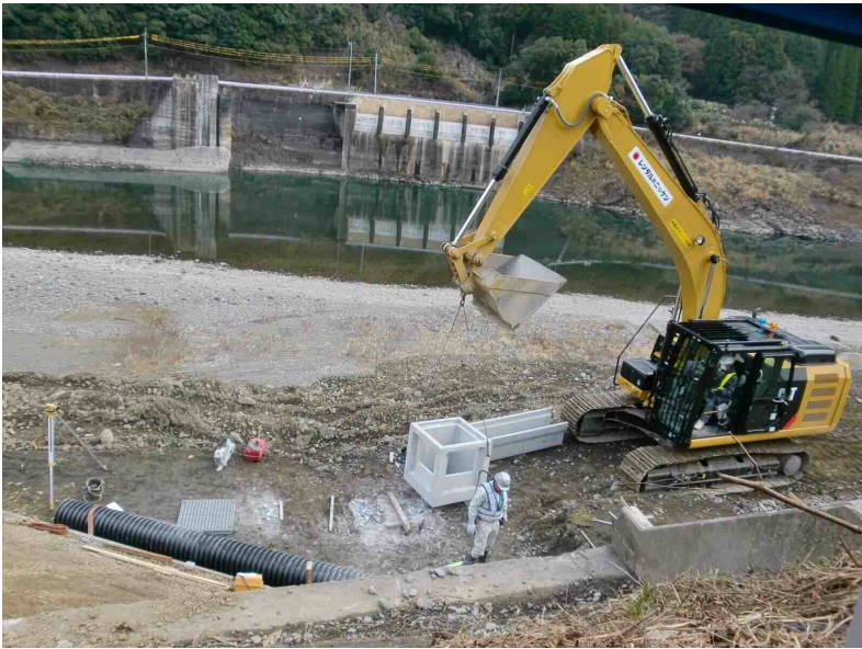
現地状況写真（平成 29 年 12 月 18 日） （大型ショベルによる堤体周辺の整備作業取壊し）
