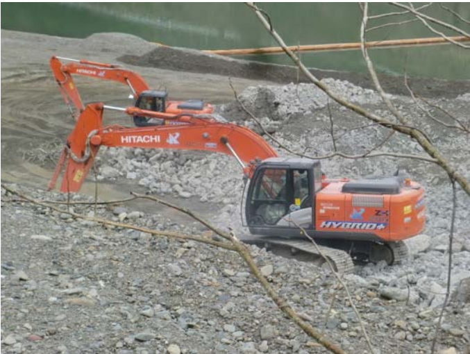
現地状況写真（構造物取壊し）
