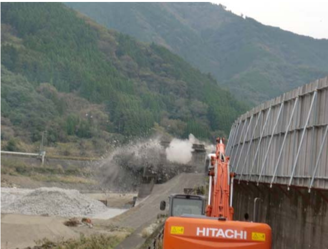
現地状況写真（発破）
