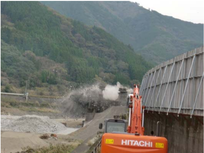
現地状況写真（発破）
