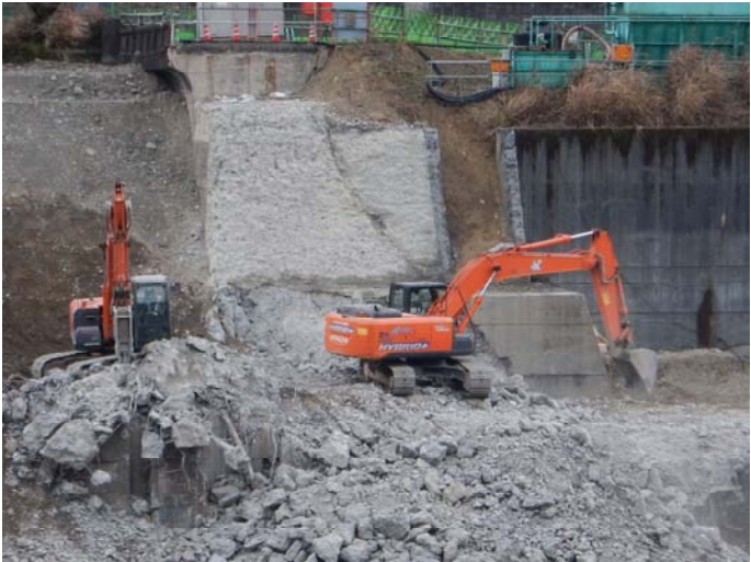
現地状況写真（構造物取壊し）
