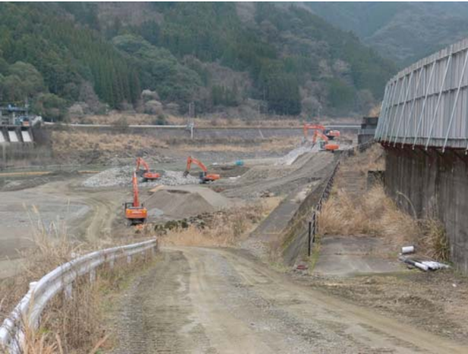
現地状況写真 (バックホウ稼働状況)
