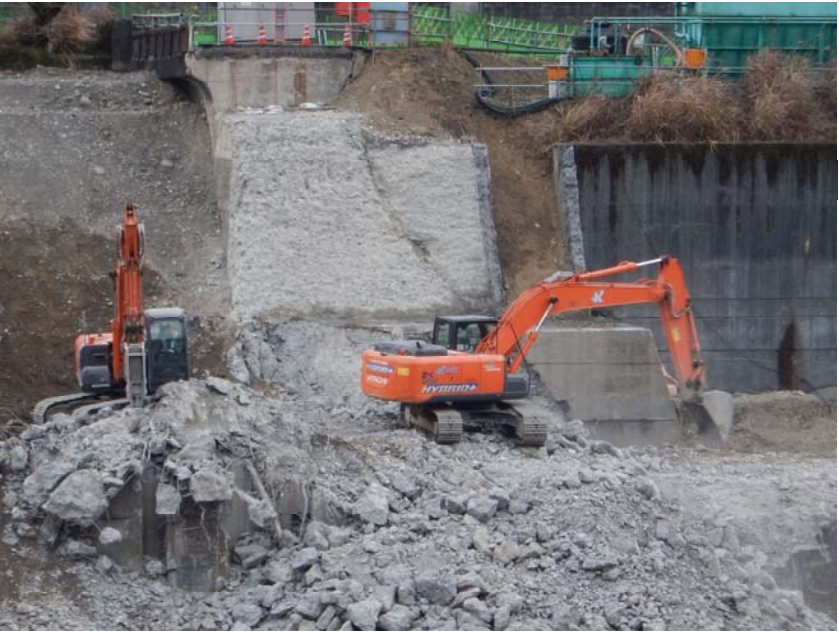
現地状況写真（構造物取壊し）
