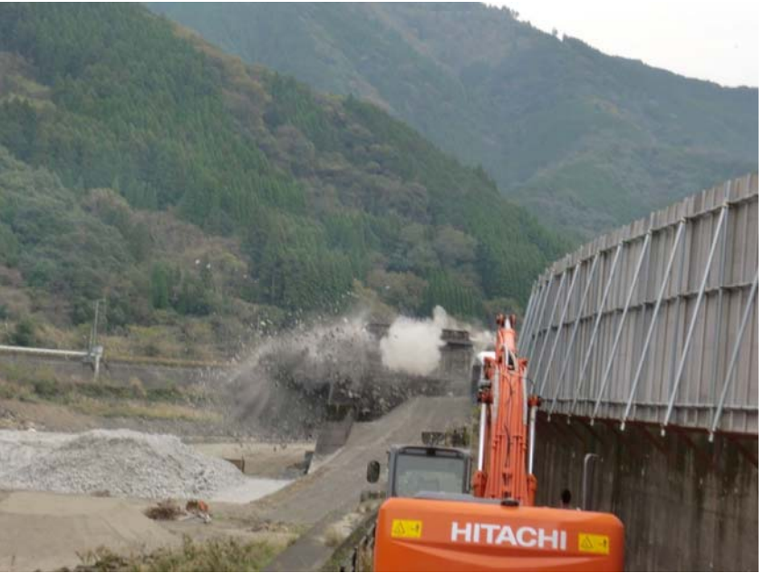
現地状況写真（発破 平成 28 年 11 月 30 日）
