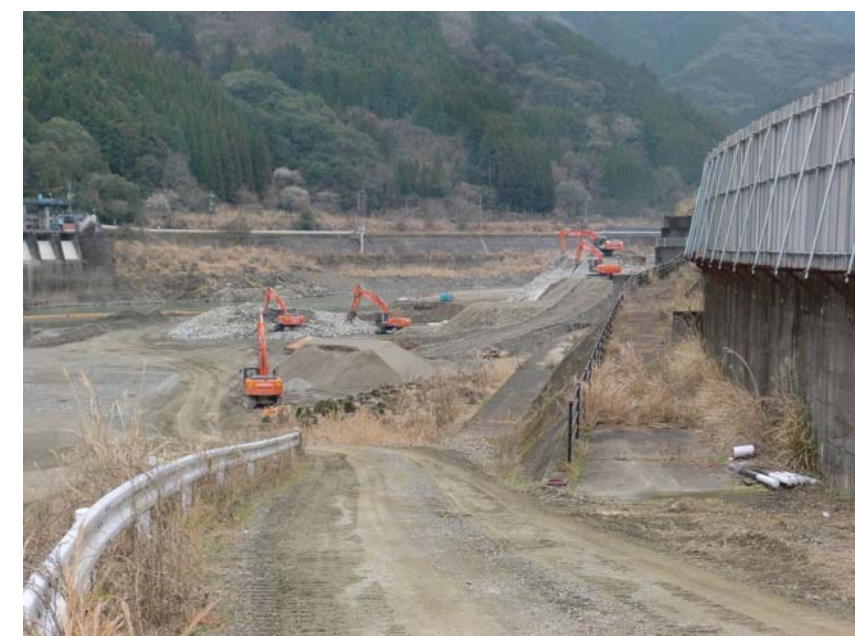
現地状況写真（バックホウ稼働状況）
