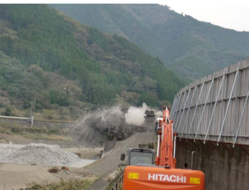
現地状況写真（発破）
