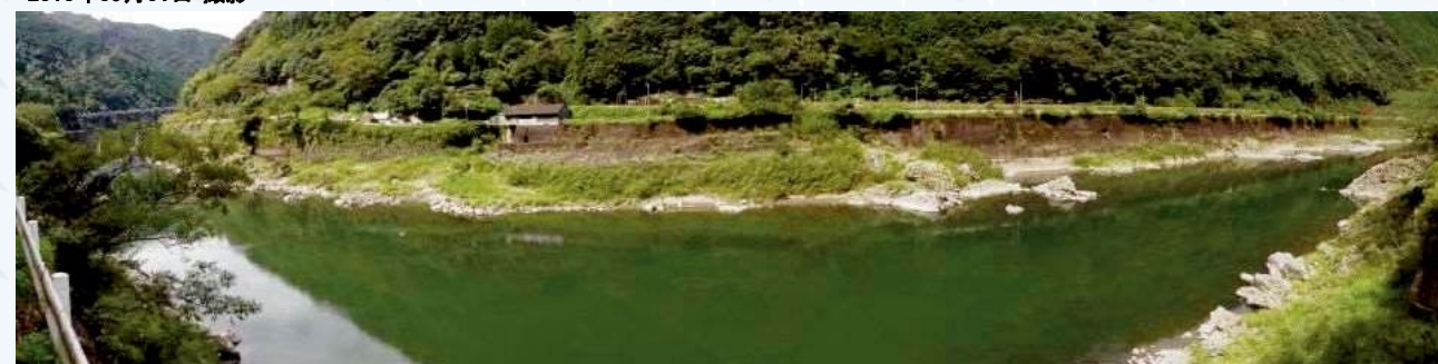
国道側から撮影(左が瀬戸石ダム) 2011年08月01日 撮影
