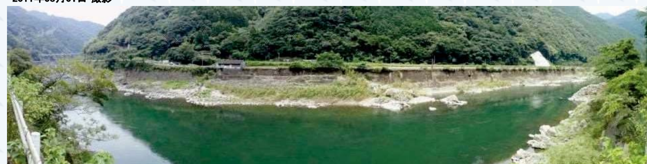
国道側から撮影(左が瀬戸石ダム) 2012年06月06日 撮影
