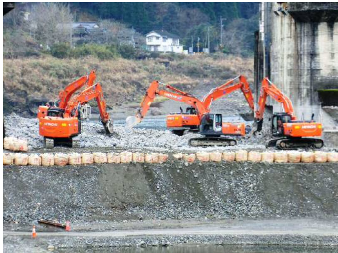
現地状況写真 (構造物取壊し)
