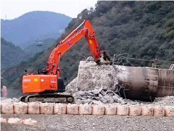
現地状況写真 (構造物取壊し)
