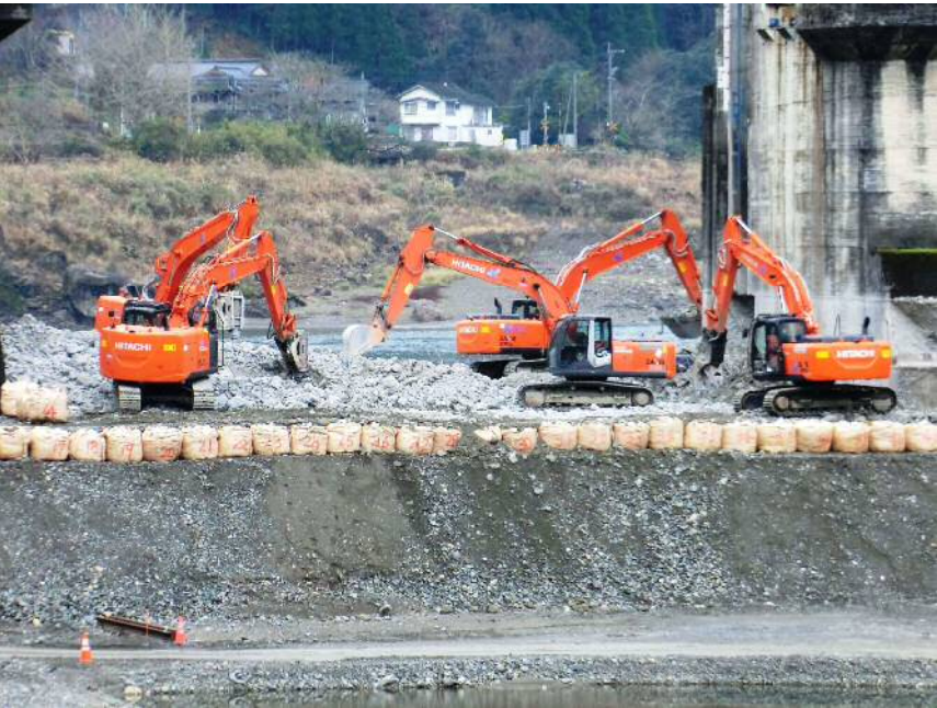
現地状況写真（構造物取壊し）
