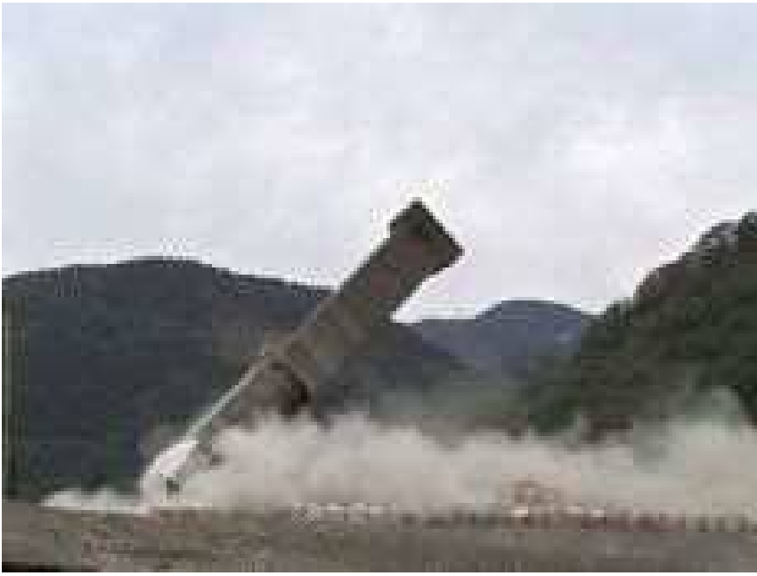
現地状況写真（発破 平成28年2月19日）
