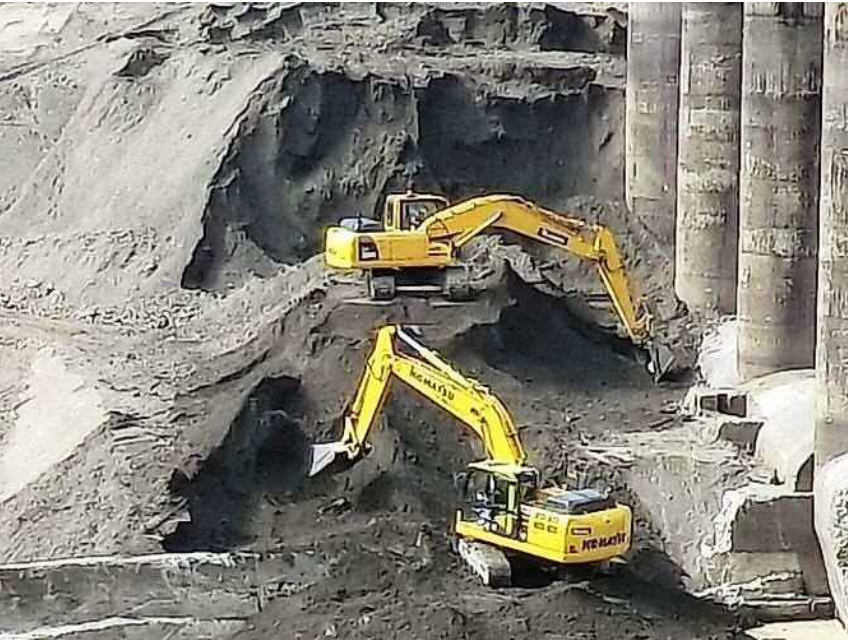
現地状況写真（構造物取壊し）
