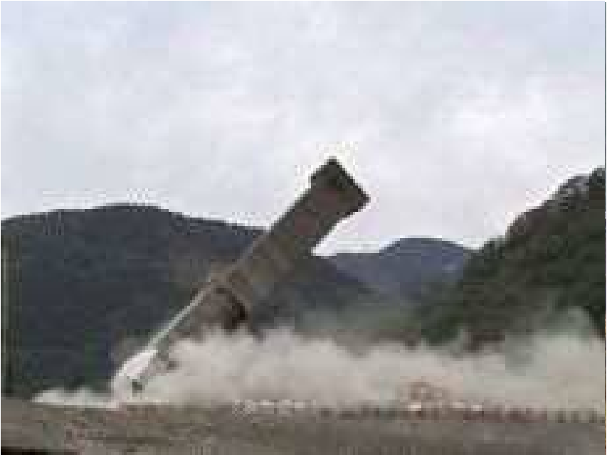
現地状況写真（発破 平成 28 年 2 月 19 日）
