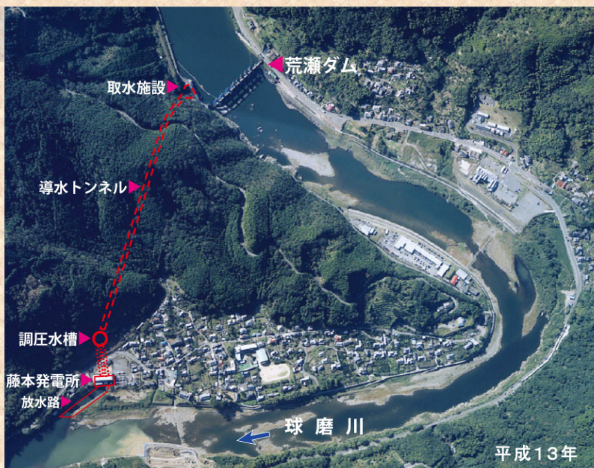
藤本発電所・放水路
